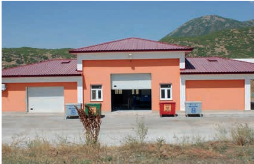
Şekil 1. Bitlis Tıbbi Atık Sterilizasyon Ünitesi [5]
