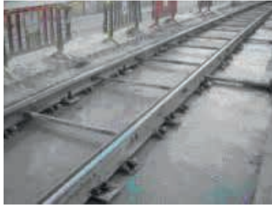
Resim-1 Tramvay hattında elastik ray bağlantı elemanı montajı
