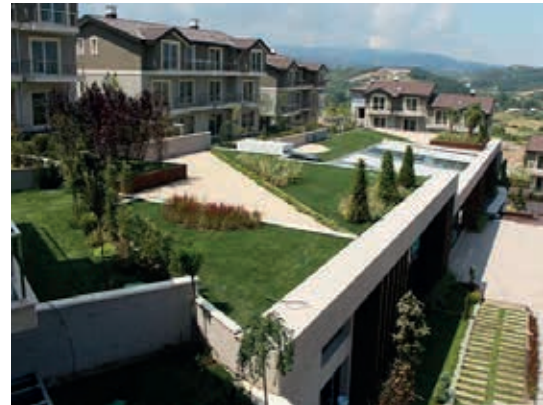
Şekil 2. Yeşil Çatı Türkiye uygulaması (Yalova) [3]
