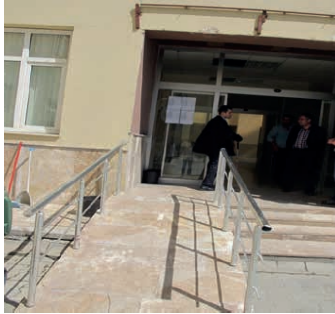
Resim 4: Yapı girişlerinde ulaşılabilirlik için rampa uygulanması Figure 4: Accessibility in the implementation of the ramp to build input
