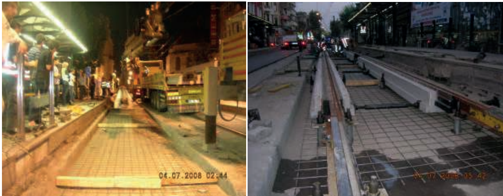
Resim-3 Hasır çelik ve kiriş betonların döşenmesi
